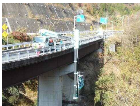
点検車による橋りょう点検状況
