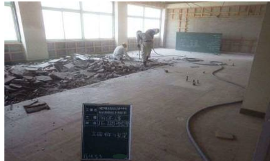
大規模改修工事
