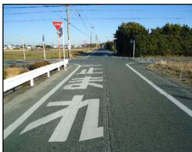
▲道路法定外表示(止まれ)の設置
