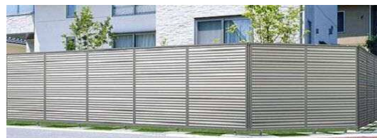
撤去・改善後
