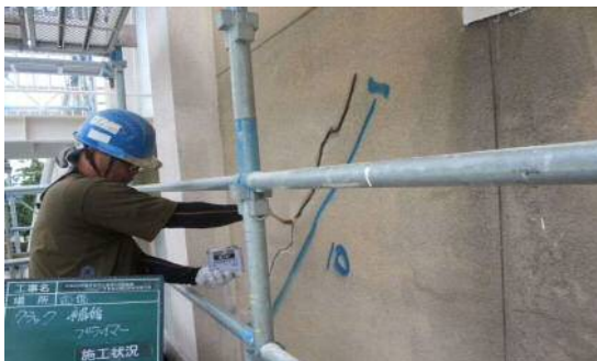
小規模改修工事（外壁改修）
