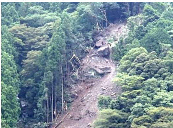
国道152号落石危険箇所（龍山町瀬尻）
