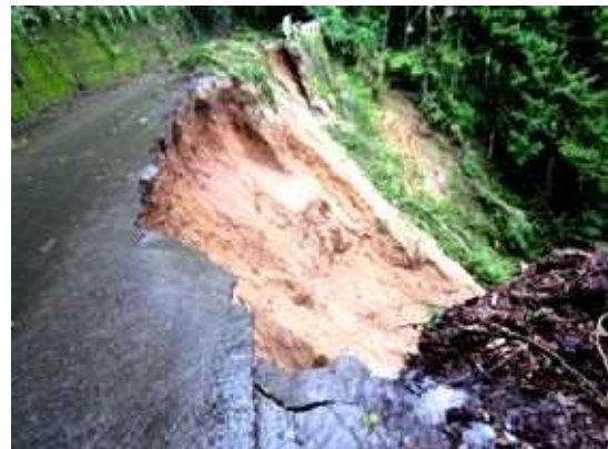
【林道天竜川線(1号箇所)被災状況】
