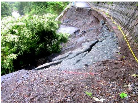
【林道白倉山線被災状況】
