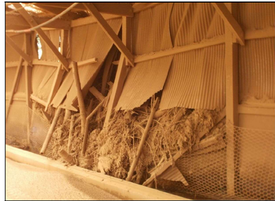
施設の破損状況
