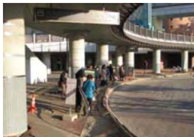
浦安市における地盤沈下の被害例
