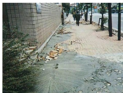
液状化による被害例
