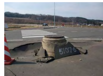
液状化の被害例
