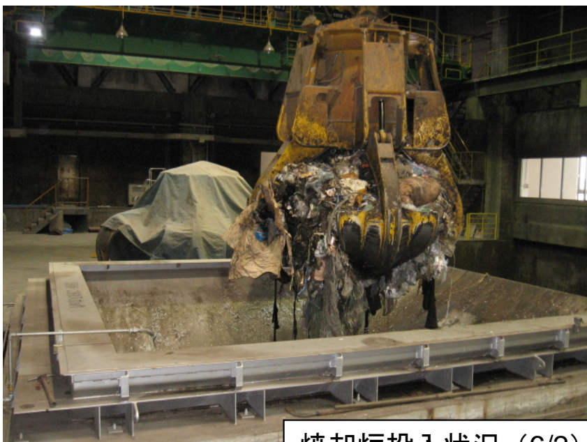
焼却炉投入状況 (6/2)
