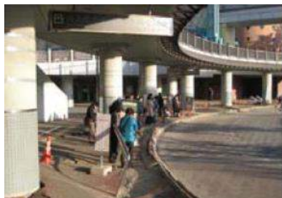
浦安市における地盤沈下の被害例
