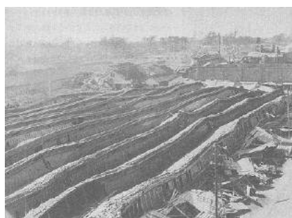
工場の倒壊の様子(高塚町、1944年)
