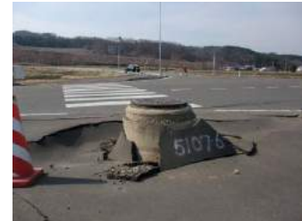
液状化の被害例
