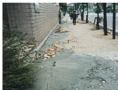
液状化による被害例
