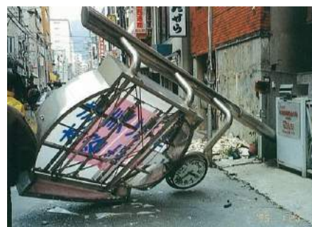
屋外物の落下による被害例
