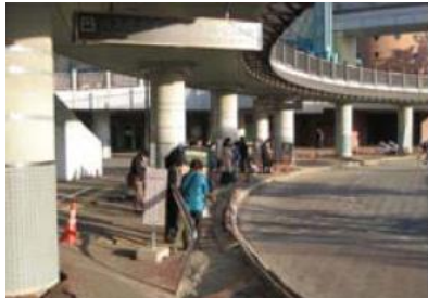
浦安市における地盤沈下の被害例
