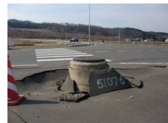
液状化の被害例
