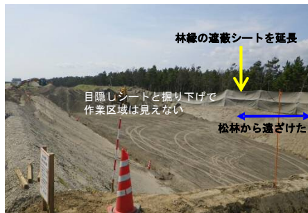
貴重種が生息する箇所への工事騒音等の影響を軽減する対策
