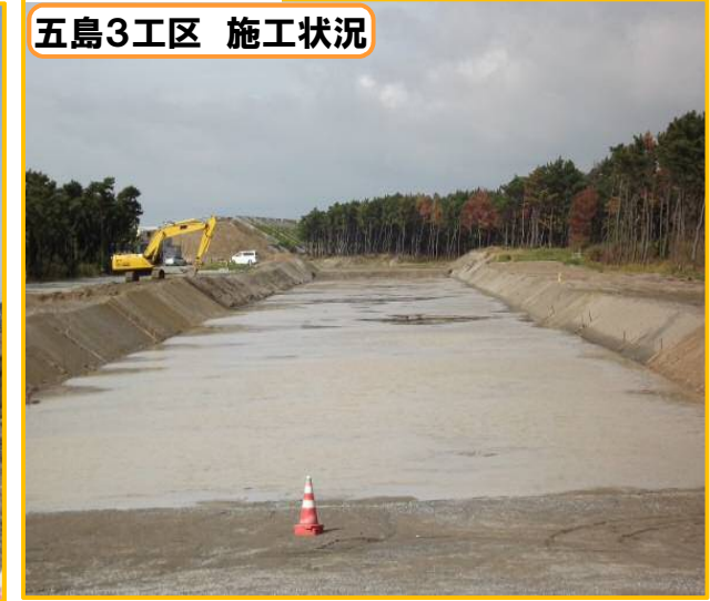
CSG打設に向け準備中
