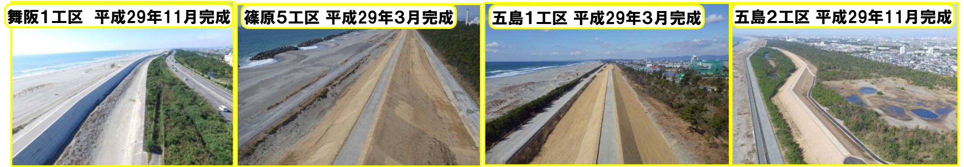
平成29年に、舞阪1工区、篠原5工区、五島1工区、及び五島2工区の4つの工区で、高さ13mの整備が竣工しました。
