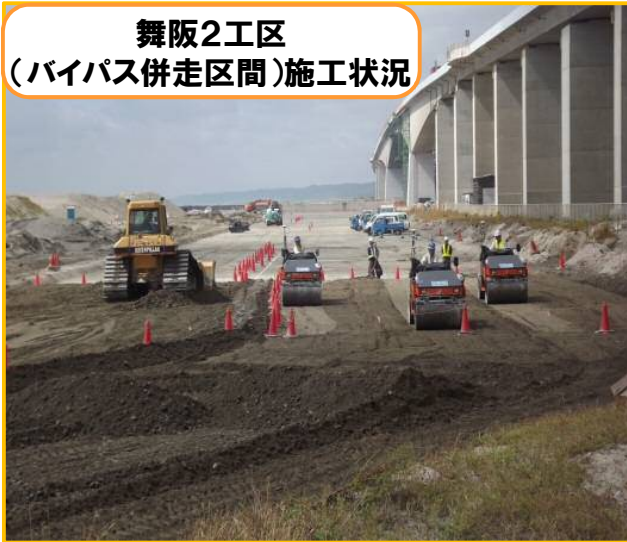
今切口側から順次工事を推進中
