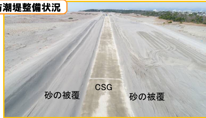
中田島砂丘の景観に配慮し、CSGを砂で覆う景観対策
