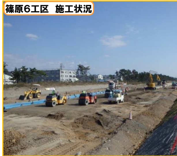
現在、既存の海岸堤防高(約T.P.9.0m) 近くまでCSGが完了
