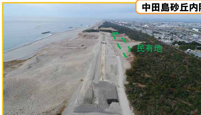
97名の共有名義の民地を避け、北側に出来るだけ寄せた位置で砂丘内を施工
