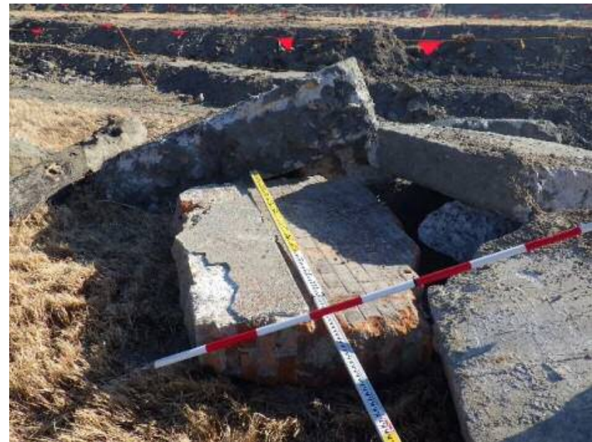
掘り出したコンクリート殻
