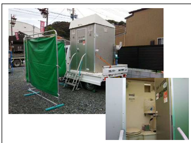
快適トイレの設置
