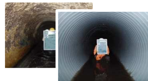
管更生実施前後の状況
