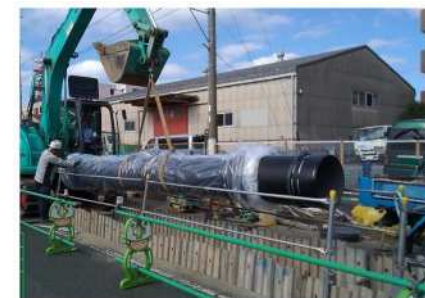
基幹管路布設状況
