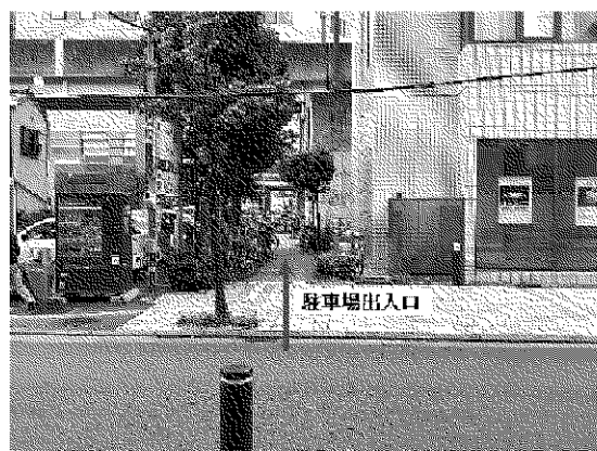
図 44- 駐車場の出入口状況
