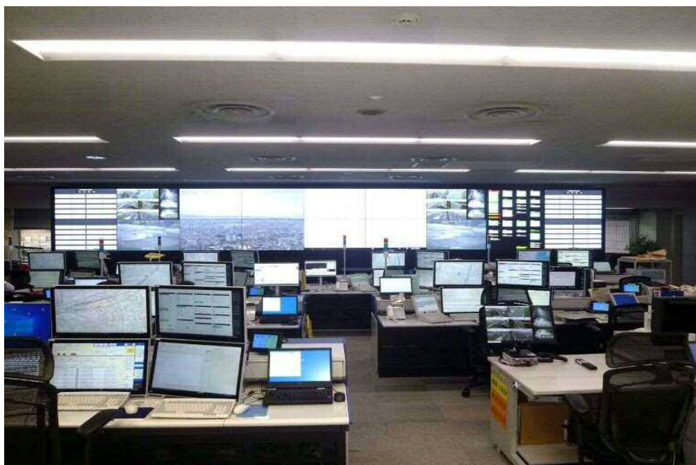
消防指令センター
