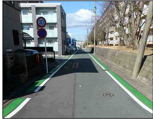
【グリーンベルト設置】
