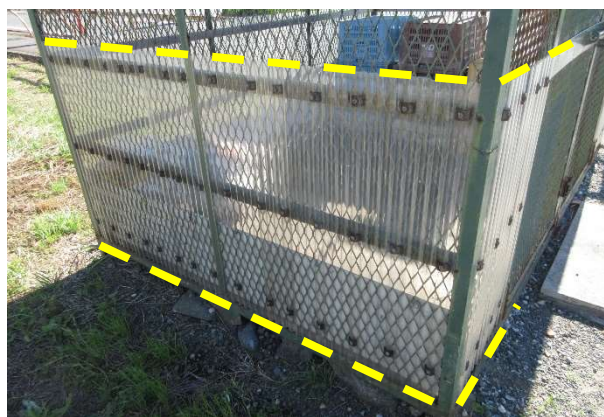
拡大像 <トタン板部分拡大>
