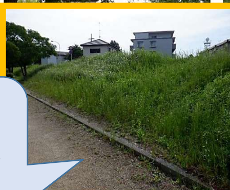
八幡瀬橋下流300m付近 着手前
