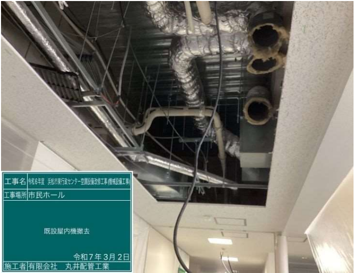
② 既設室内機撤去
