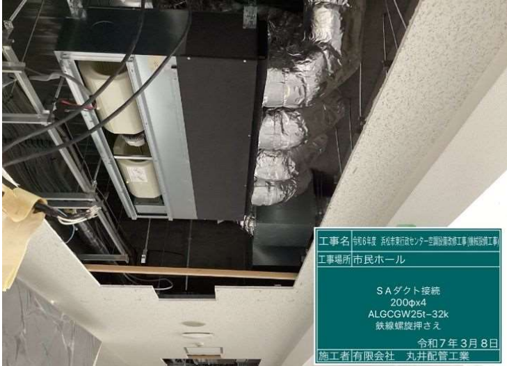
③ 新設室内機吊り込み、ダクト接続
