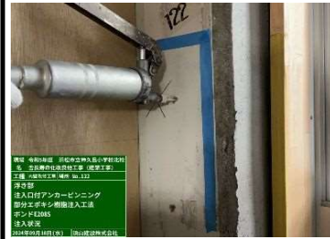
④内外装浮き部注入状況
