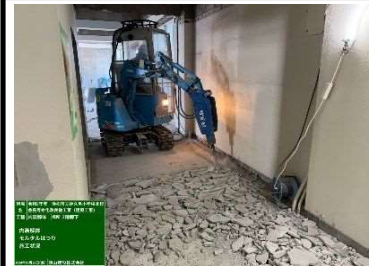
①解体時電動バックフォア使用
