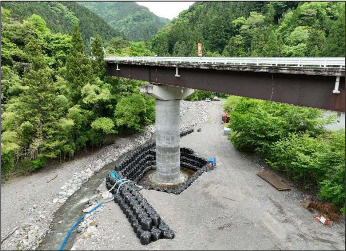
P1橋脚コンクリート巻立て完了時
