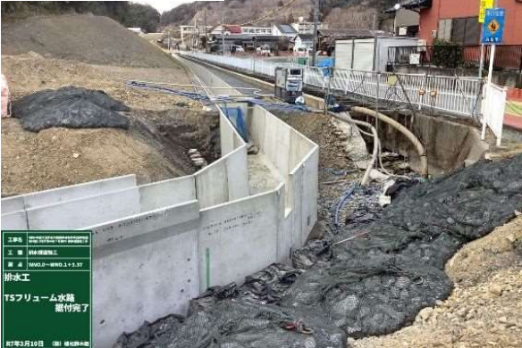
既設排水路新設水路重複箇所施工状況
