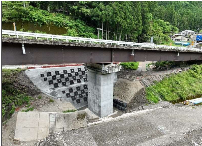
P2橋脚コンクリート巻立て完了時
