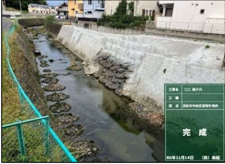
◆応急復旧工完了 写真
