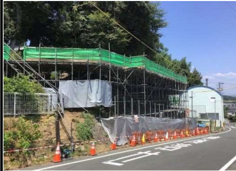
施工用作業構台設置 全景(起点から終点へ)
