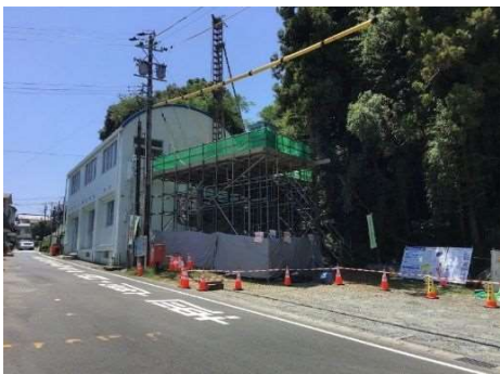
施工用作業構台設置 全景(終点から起点へ)
