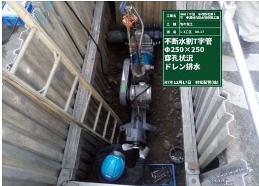
不断水分岐工
