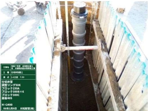
仕切弁樹設置
