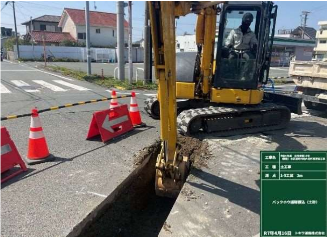
県道掛塚舞阪竜洋線 管布設状況 DGXφ150mm
