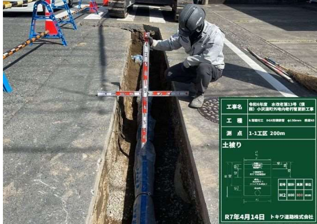
県道掛塚舞阪竜洋線 管布設状況 DGXφ150mm
