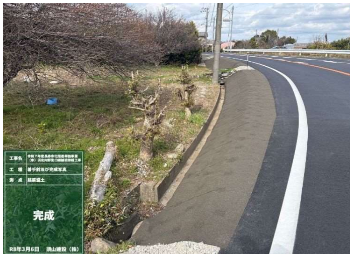
アスファルト系法面保護シートの活用 で路肩からの雨水侵食を実施（創意工夫）
