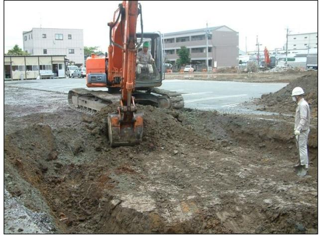
② 表面の土（約1m）を重機で掘削
