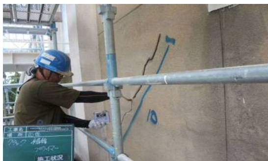
小規模改修工事（外壁改修）
