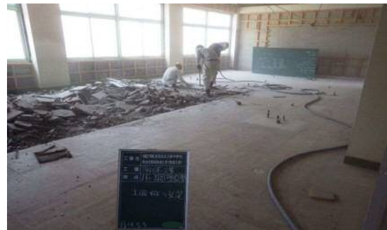
大規模改修工事
