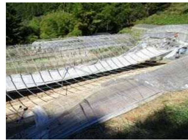
台風第19号による施設被害
