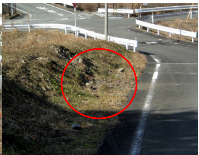
【法面乗上げ箇所】
