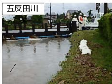
平成29年6月豪雨による堤防越水
