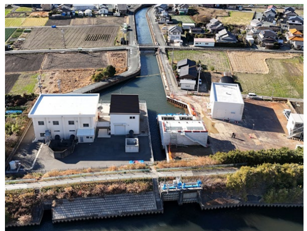
▲ 高塚川下流部への排水機場設置
