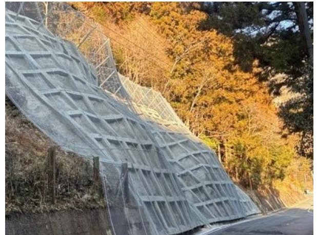
▲ 国道 152 号道路斜面对策
