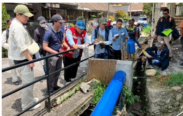
▲ 水管橋調査 (バンドン市内)
