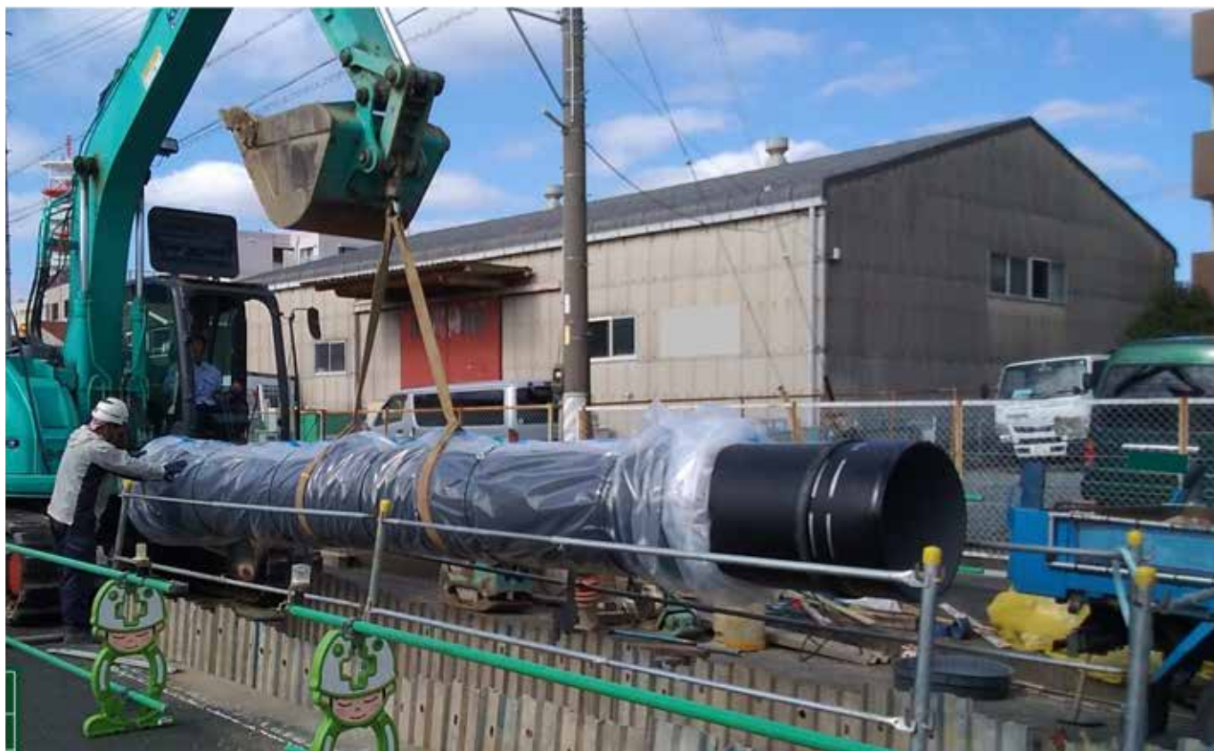
▲ 水道基幹管路耐震化
