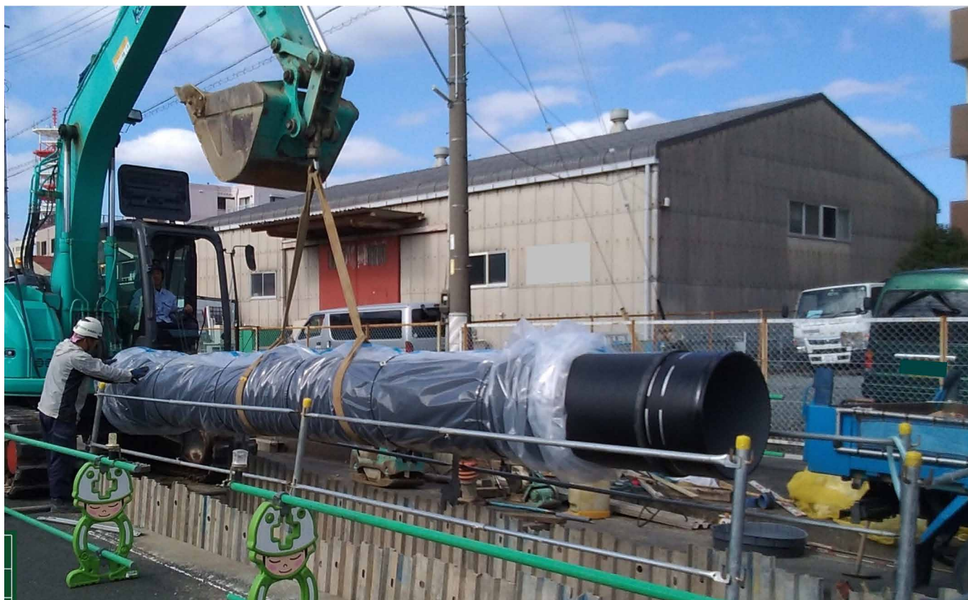
▲ 水道基幹管路耐震化
