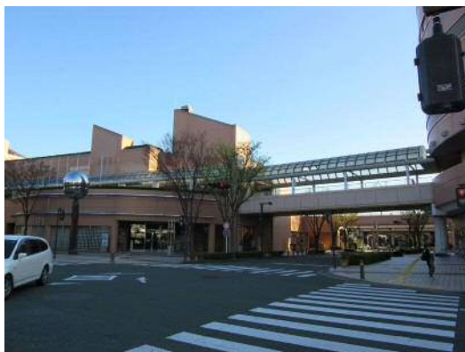
ガラスアーケード工事箇所
