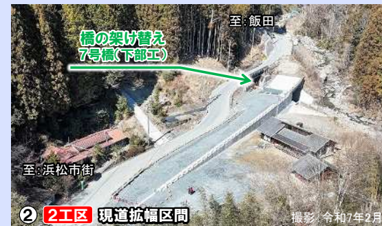
② 2工区 現道拡幅区間
