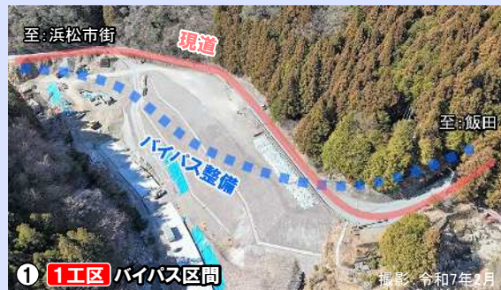
① 1工区 バイパス区間
