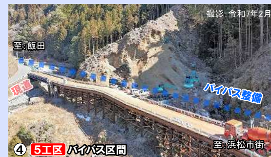
④ 5工区 バイパス区間
