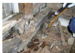
床下の腐朽
