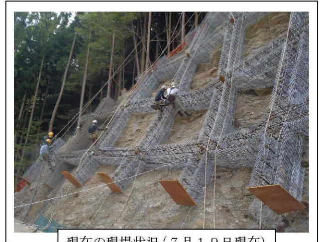
現在の現場状況（7月19日現在）
