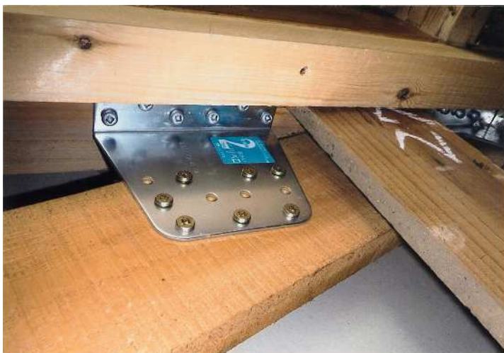
壁補強工事(構造用合板+筋かい)
