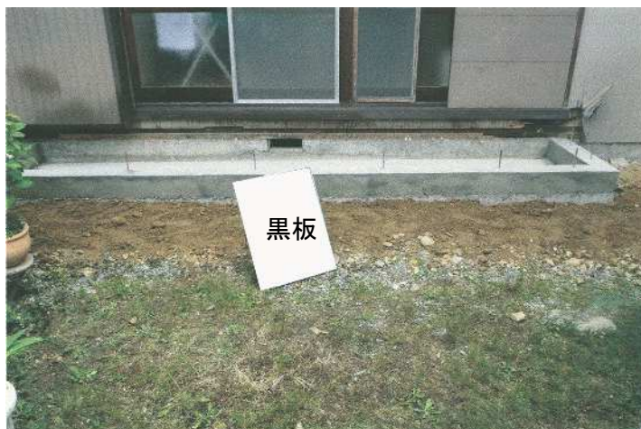
基礎補強工事
