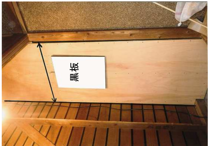
壁補強工事(構造用合板+筋かい)
