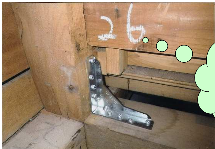
壁補強工事(構造用合板+筋かい)
