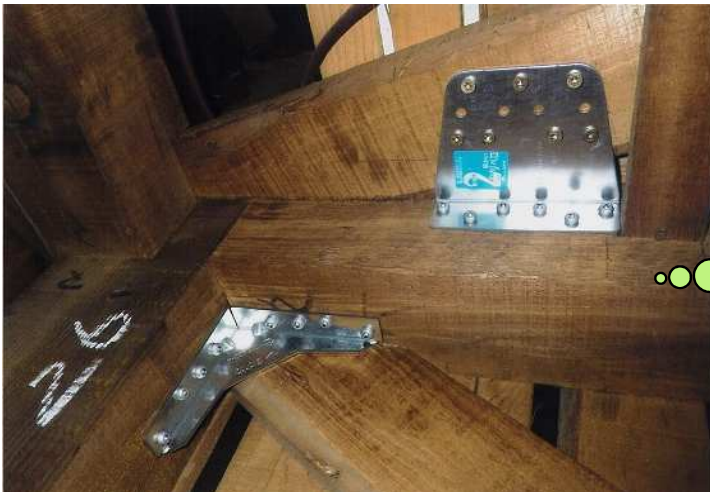
壁補強工事(構造用合板+筋かい)
