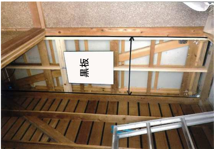
壁補強工事(構造用合板+筋かい)
