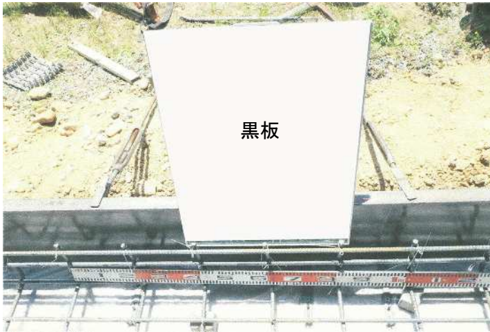
基礎補強工事
