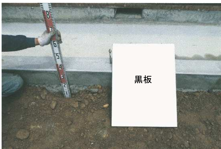
基礎補強工事
