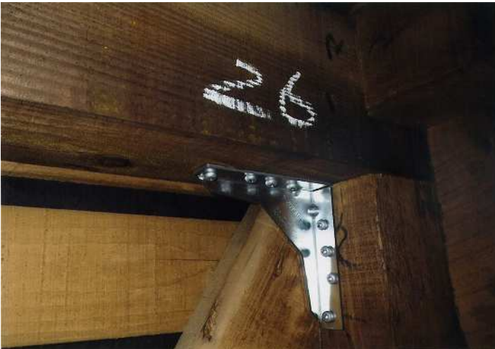
壁補強工事(構造用合板+筋かい)
