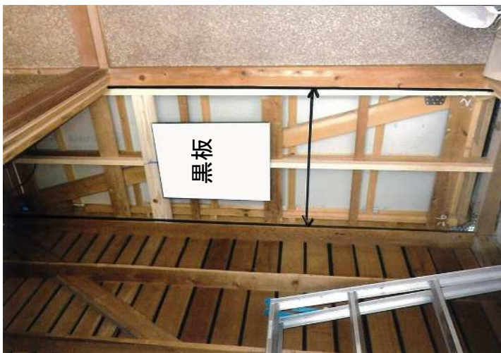
壁補強工事(構造用合板+筋かい)
