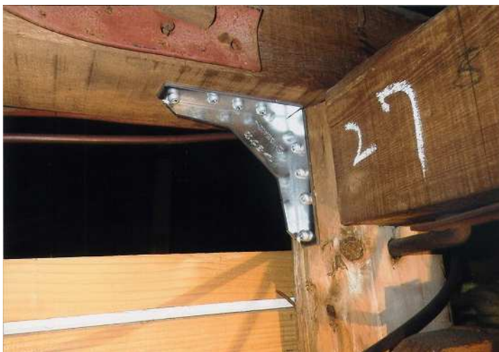
壁補強工事(構造用合板+筋かい)
