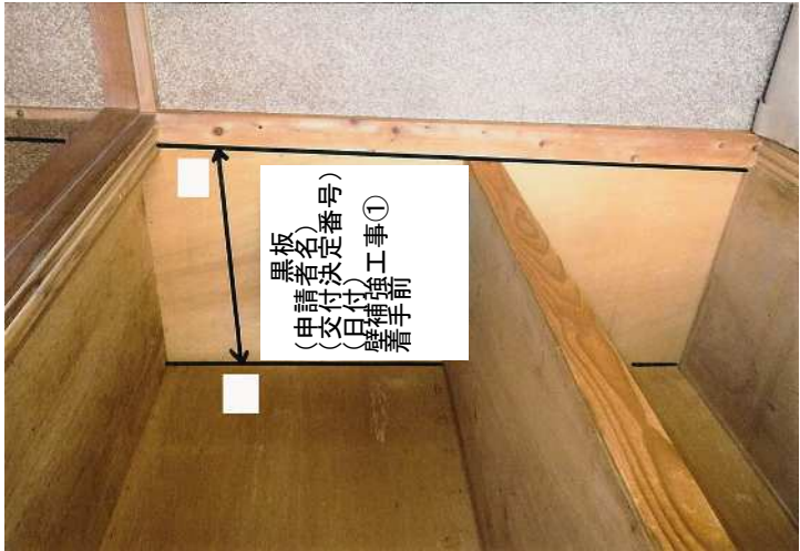
壁補強工事(構造用合板+筋かい)
