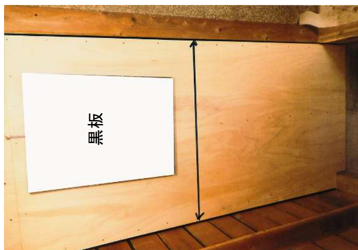
壁補強工事(構造用合板+筋かい)
