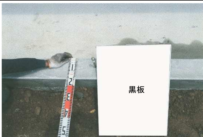
基礎補強工事
