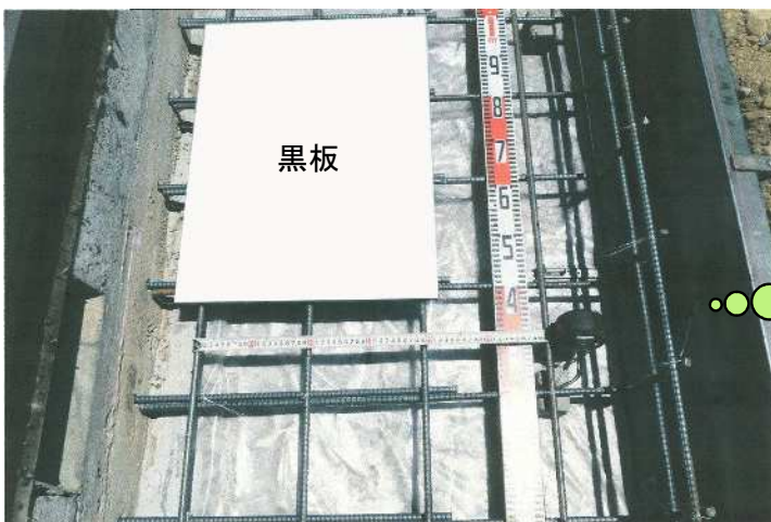
基礎補強工事
