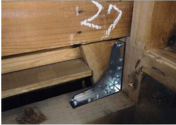
壁補強工事(構造用合板+筋かい)
