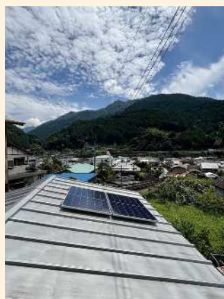
借家の屋根に設置した太陽光パネル
