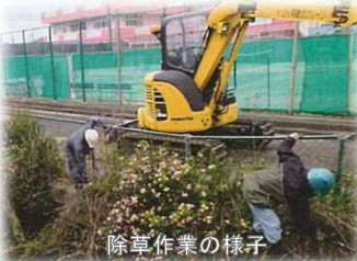
河床掘削の様子
