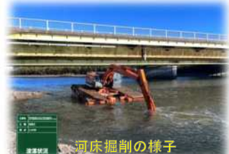
河床掘削の様子
