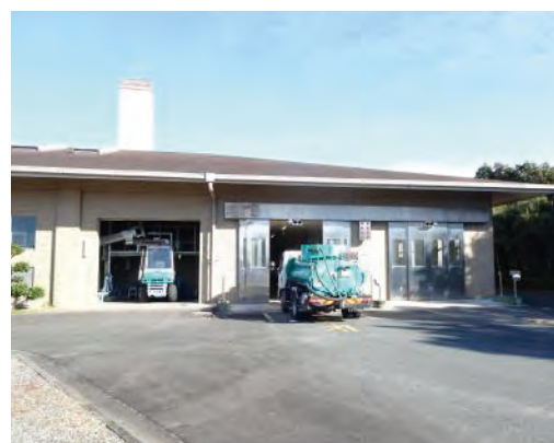
東部衛生工場(し尿処理施設)
