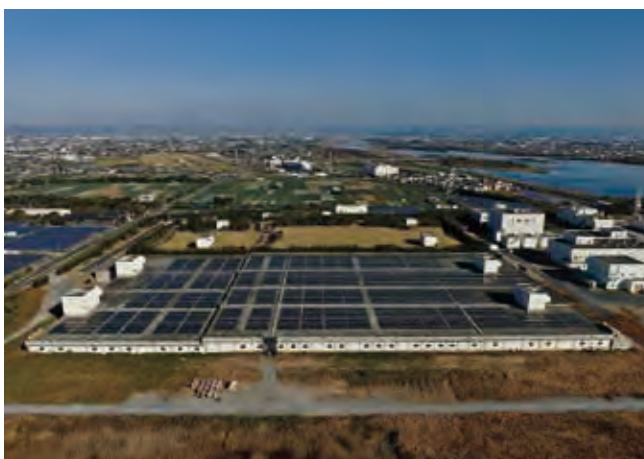
太陽光発電（西遠浄化センター）
