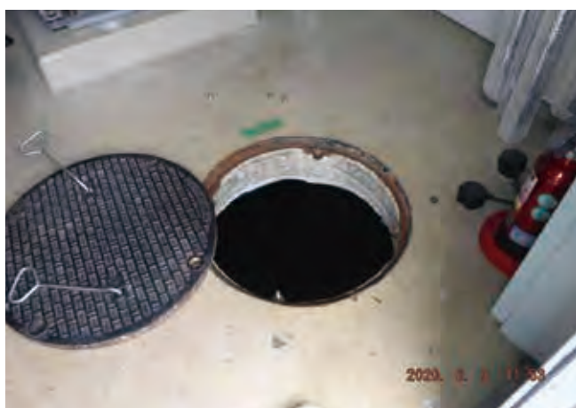
地下水の水質調査
