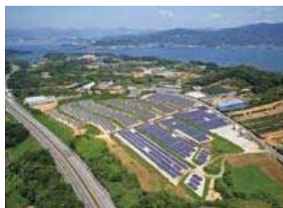
【大規模太陽光発電所】
