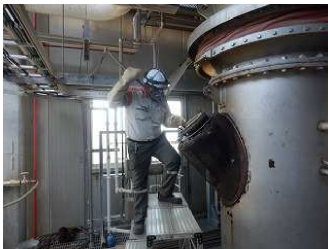
図 9 汚泥焼却炉リターン管閉塞確認及び異物除去作業の確認
