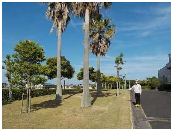
図 10 環境整備の確認（浜名中継ポンプ場）
