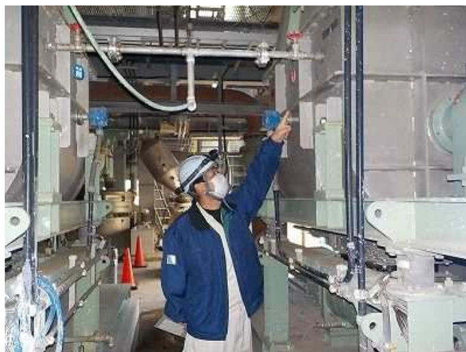
図 11 汚泥焼却炉閉塞防止対策（消石灰添加箇所）の確認
