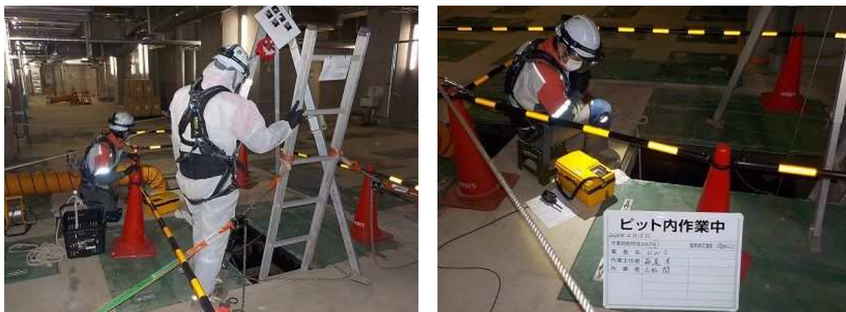
図 4 酸素欠乏危険作業状況確認
