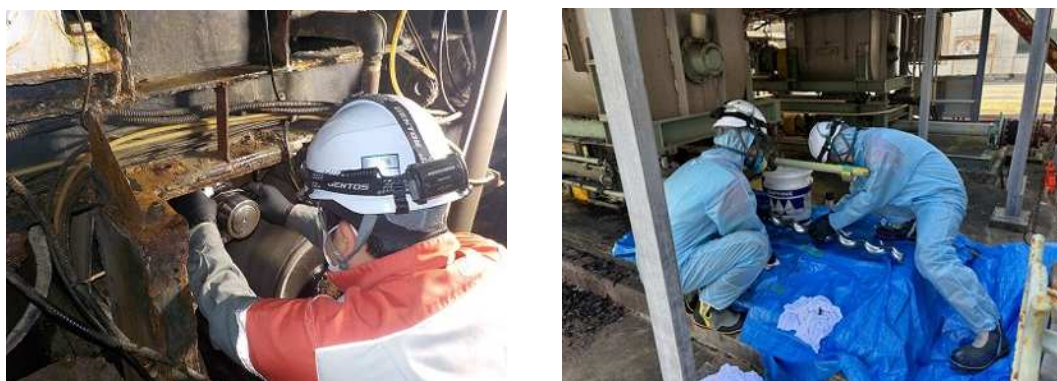
図 15 内製化によるベルトプレス脱水機及びケーキ投入ポンプ修繕状況確認
