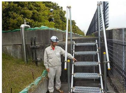
図9 安全対策（転落防止階段設置）
