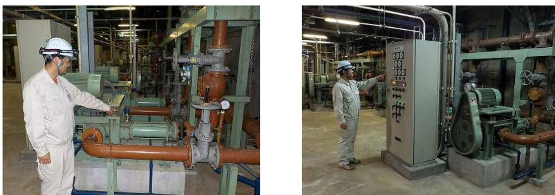
図 13 内製化による汚泥ポンプ部品取替状況
