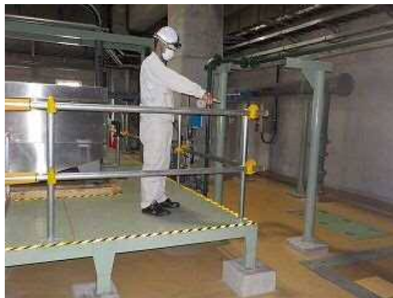
図 8 安全対策後（転落防止柵設置）
