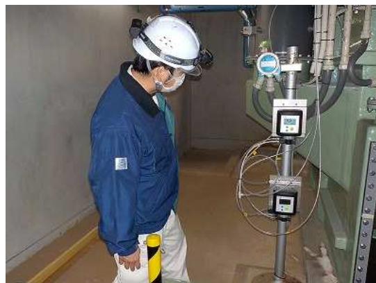
図 8 臭気モニタリングシステムの確認及び汚泥貯留槽へ消臭剤添加の確認
