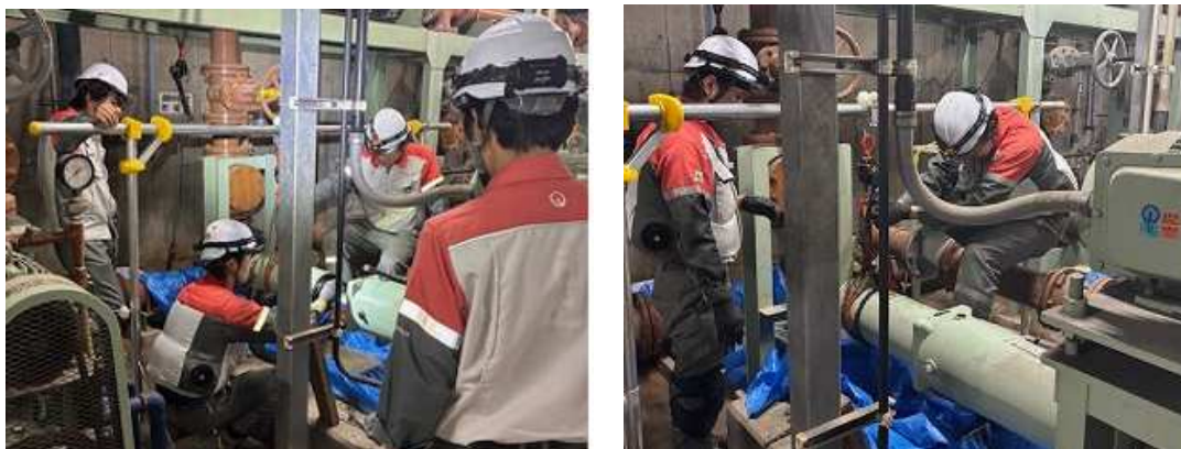
図 17 内製化による一軸偏心ねじポンプ修繕状況の確認
