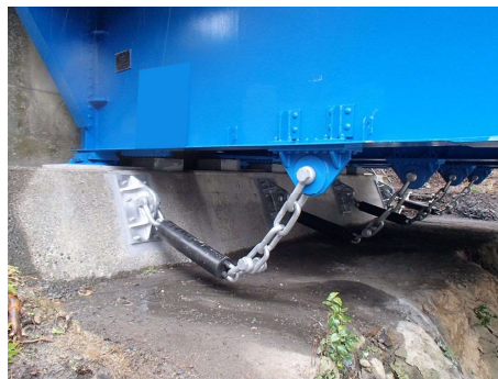
写真 2-1 耐震補強の事例（左；横山橋(橋脚の補強) 右；新長久橋(落橋防止システムの設置)
