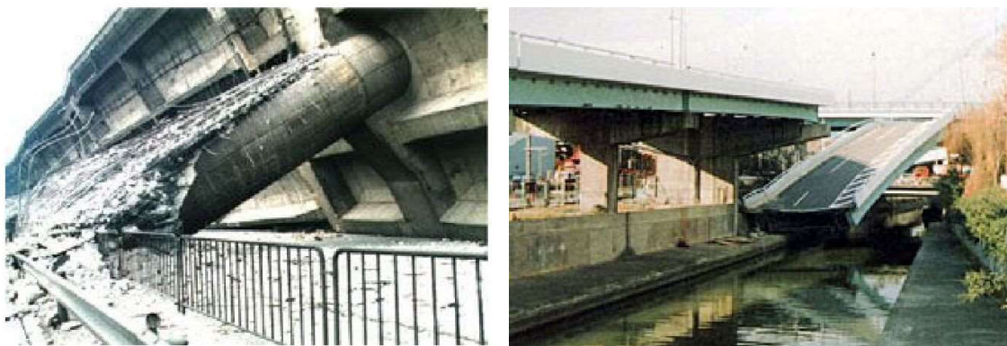
写真 1-1 兵庫県南部地震での被害例
