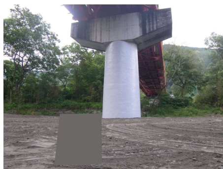
写真 2-1 耐震補強の事例（左；横山橋(橋脚の補強) 右；新長久橋(落橋防止システムの設置)
