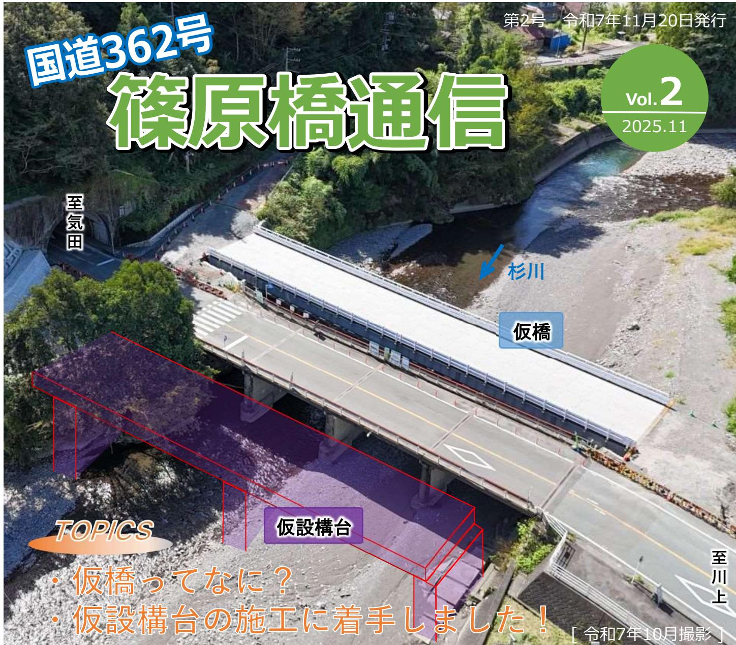
「仮橋」には、河川内で工事を施工するために直接必要なもの（工事用仮橋）と工事の際に道路交通を迂回させるために必要なもの（迂回路のための仮橋）があります。
