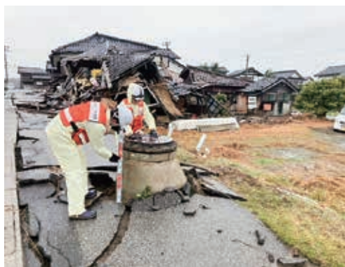
能登半島地震で被災した下水道の復旧活動に従事する本市職員(石川県珠洲市)
