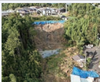
天竜区緑恵台で発生した盛土による土砂崩れ
