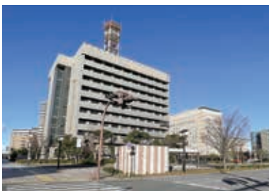
シビックコア地区に立地する静岡県浜松総合庁舎
