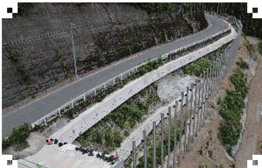
整備中の国道152号(池島・大原区間)第5工区
