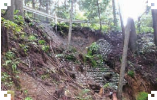
法面が崩壊した市道春野サルゴダ大時線
