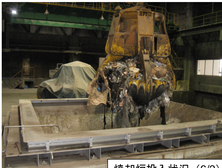
焼却炉投入状況 (6/2)
