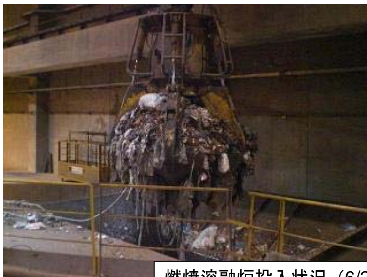
燃焼溶融炉投入状況 (6/25)
