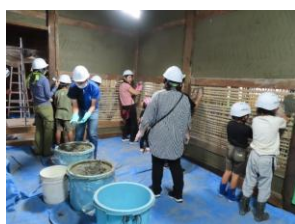
普段一般公開では入れない、修復工事現場の見学会や体験会
